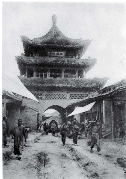
图21 沙畹所摄咸阳钟楼, 光绪三十三年(1907)
