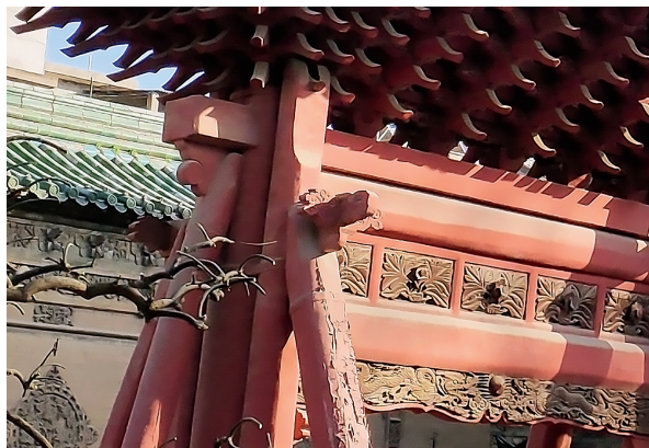
图16 化觉巷清真寺牌坊上的斜插花板 (曹尚宏 摄)
