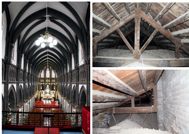
图12 沈阳天主堂天花(假结构)和屋顶结构(真结构) (胡雪卿 摄)
