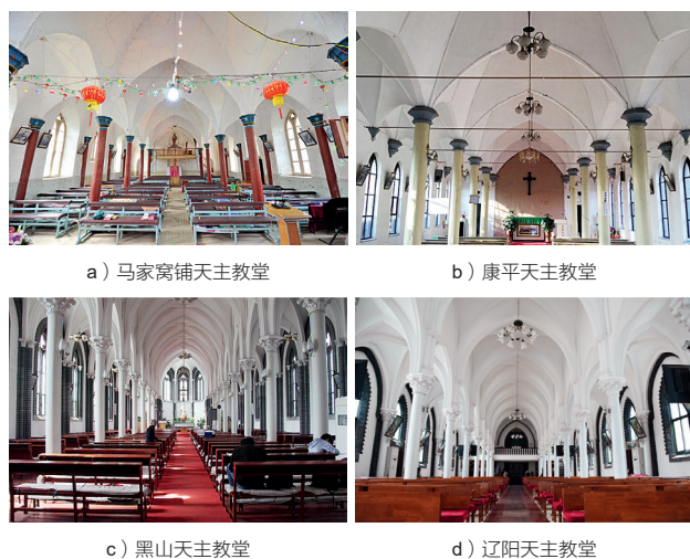
图13 肋骨拱吊顶形式 (胡雪卿 摄)
