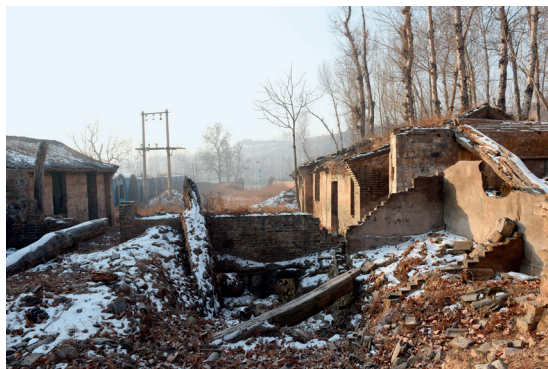
图48 修缮前的“柏树磨”正房遗址, 北向南 (2017年, 师高星 摄)
