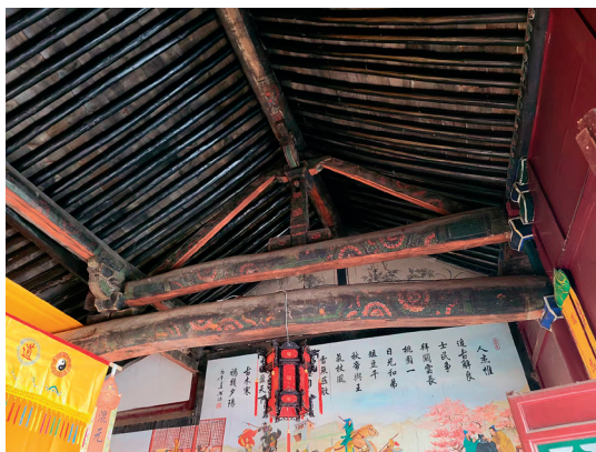
图 28 赵庄关帝庙正殿梁架 (2024年4月，党晟 摄)
