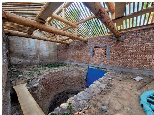
图49 修缮中的“柏树磨”正房内, 东南向西北 (2024年4月, 党晟 摄)
