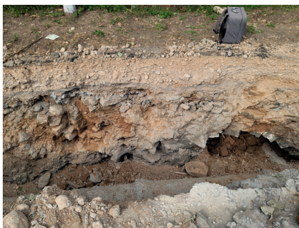
图 11 沟槽东壁暴露的砖墙和券洞口 (党晟 摄)
