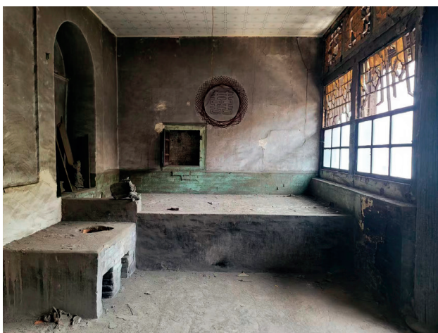
图 52 杨家大院第三进院北厢房二楼房间，西向东 (2024年7月，党晟 摄)
