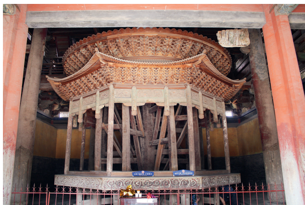
图4 隆兴寺转轮藏现状照片 (2009年7月, 天津大学测绘调查照片, 王蕊佳 摄)
