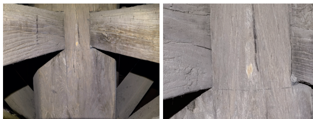
图 24 转轮藏立轴取样位置,可见立轴上墨线 (2022 年 7 月,作者自摄)
