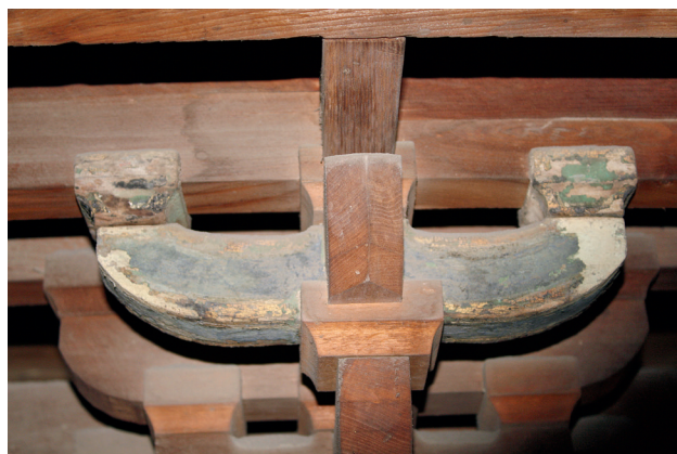
图5 隆兴寺转轮藏平坐上的旧料科拱构件 ⑥ (2009年7月, 天津大学测绘调查照片, 王蕊佳 摄)
