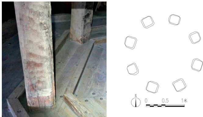
图 26 转轮藏帐身内圈柱现状照片及其与帐坐内圈柱截面对照图 (左图为 2022 年 7 月作者自摄, 右图为作者据 2020 年 10 月天津大学点云自绘)
