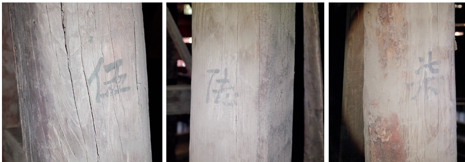
图 21 帐身内圈柱径向外表面上的墨书数字（墨书数字编号顺序见图 16，表 2）（2020 年 10 月作者自摄）
