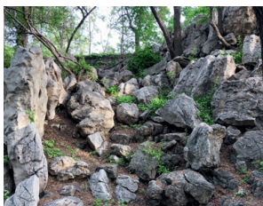
图 27 三号山体 B 区，坍塌的东山洞
