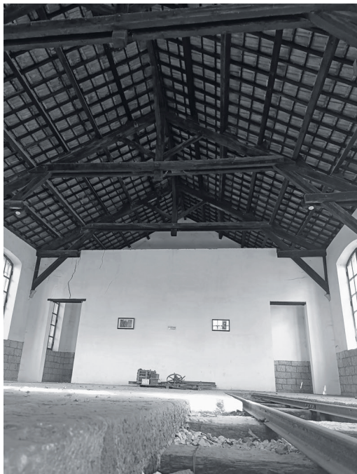
图6 滇越铁路碧色寨车站 另担房内部
