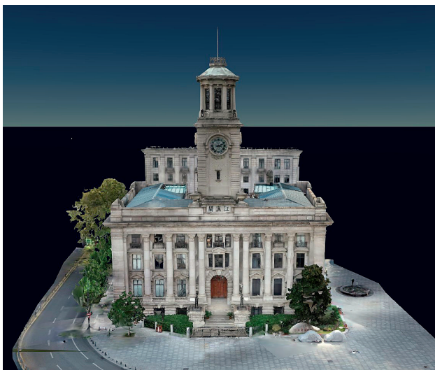
图4 江汉关大楼正立面 (华中科技大学建筑与城市规划学院摄影测量模型)
