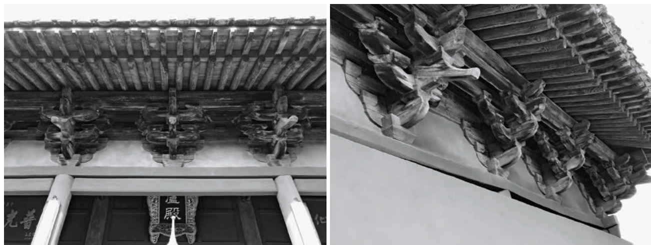
图7 毗卢殿外檐斗拱（左：前檐柱头与补间铺作；右：东山面斗拱） （左：赵萨日娜 摄；右：赵寿堂 摄）
