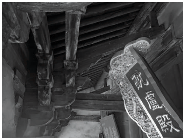
图3 毗卢殿前檐斗拱里跳(昂尾有凹槽痕迹) (赵萨日娜 摄)
