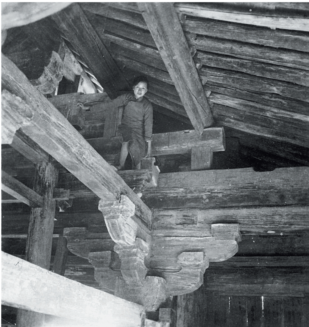
林徽因测绘正定开元寺钟楼（1933年）
