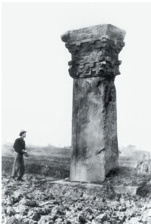
梁思成测绘渠县王家坪无名阙（1939年）
