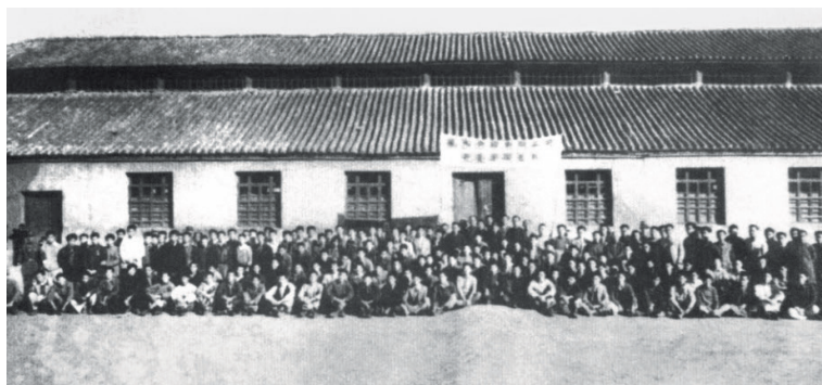
图 32 铺设瓦屋顶的图书馆
