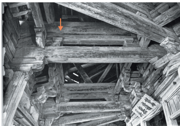
图3 应县木塔二层外槽内侧（二） （陈明达，应县木塔[M]，2版，北京：文物出版社，1980。）
